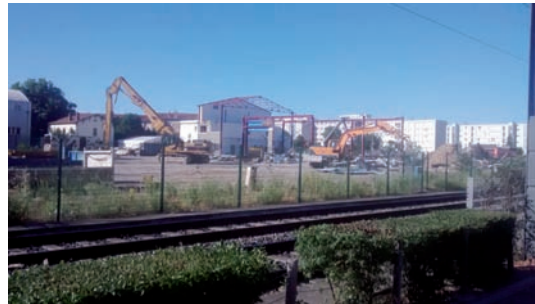
Destruction de hangars, quartier de la Soie (Villeurbanne)
