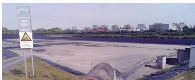
Vue d'ensemble du bassin de rétention de Djangha Reinhardt
