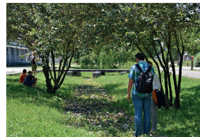
La ville perméable s'installe peu à peu (Noue conçue en « rivière sèche » sur le Campus LyonTech la Doua)
