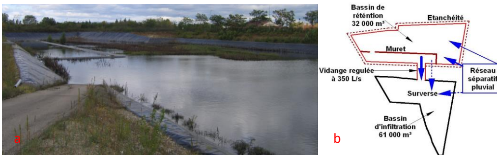
Fig. 1. Bassin de retenue-décantation Django Reinhardt – Chassieu (Est Lyon) – (a) Bassin en eau lors d'une pluie, (b) configuration globale du bassin (la partie étudiée est le compartiment de rétention)
