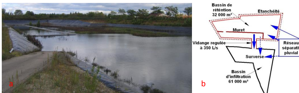
Fig. 1. Bassin de retenue-décantation Django Reinhardt – Chassieu (Est Lyon) – (a) Bassin en eau lors d'une pluie, (b) configuration globale du bassin (la partie étudiée est le compartiment de rétention)
